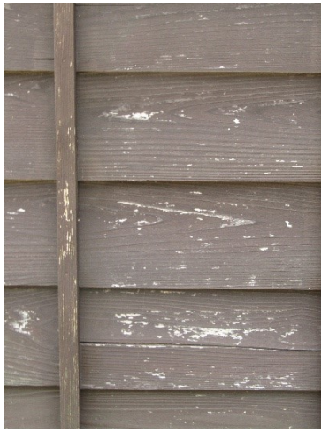
↑ 塗装が剥離している下見板 →
