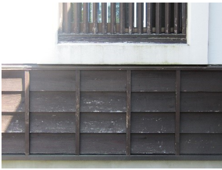
↑ 塗装が剥離している下見板 →
